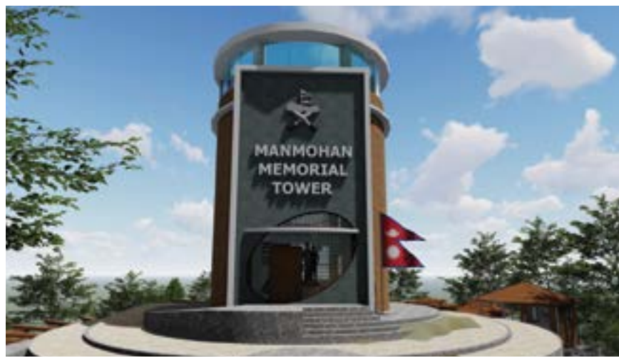
महालक्ष्मी नगरपालिकाको निर्माणाधिन गौरवको योजना मनमोहन मेमोरियल टावर, लाकुरीभन्ज्याङ
